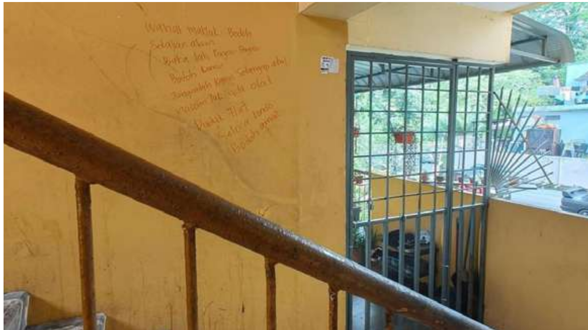
PEMASANGAN pintu jeriji di salah sebuah rumah Flat Seksyen 2 Wangsa Maju yang menghalang laluan pejalan kaki.
